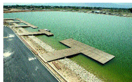
^ Schinias: particolare pontili imbarco-sbarco
