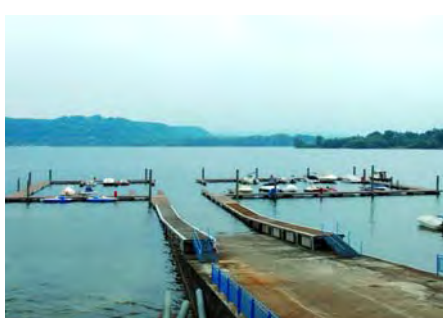
DORMELLETO (NO) Cantiere S. Lucia: un nuovo porticciolo galleggiante sul Lago Maggiore
