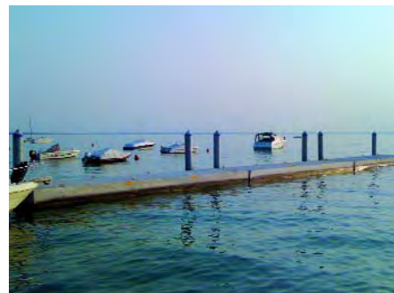
BARDOLINO (VR) Frangionde galleggianti sul Lago di Garda a protezione degli ormeggi di Roccavela
