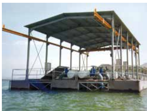
Stazione di pompaggio, Lago di Naro (Agrigento)
