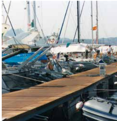
Pontile tipo FE-3 a galleggiamento discontinuo
