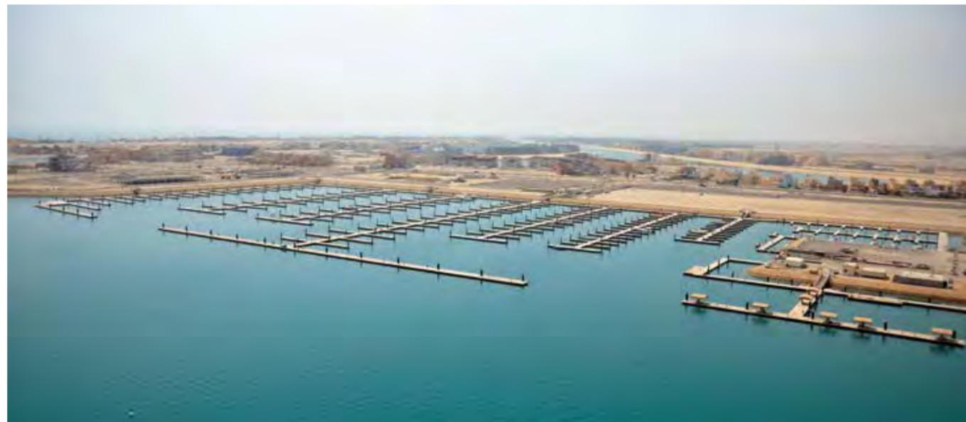
allo specifico lay out ed alle più rilevanti dimensioni della imbarcazioni: pontili e frangionde monolitici in cemento armato, con larghezza di 3 e 4 m e lunghezza fino a 20 m, con dislocamento di 65ton e finger; ancora in cemento armato, con dimensioni fino a 30x3 m.
