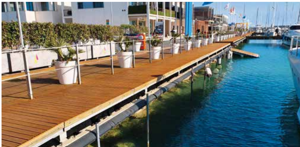
Banchina prefabbricata, Marina Cala de' Medici, Rosignano - Livorno
