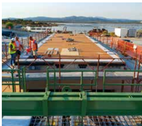
Cantiere produzione frangionde 20x6 m a Olbia
