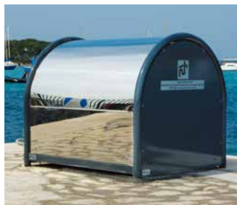
Stazione di pompaggio acque nere e oli esausti
