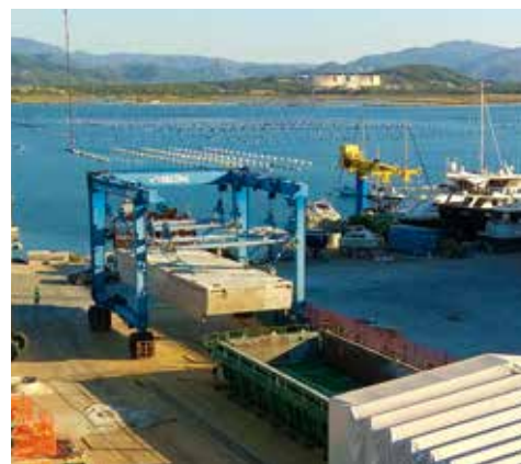
Cantiere produzione frangionde 20x6 m a Olbia
