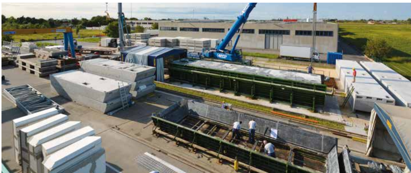
Area produzione grandi manufatti in cemento armato, stoccaggio e spedizione materiali
