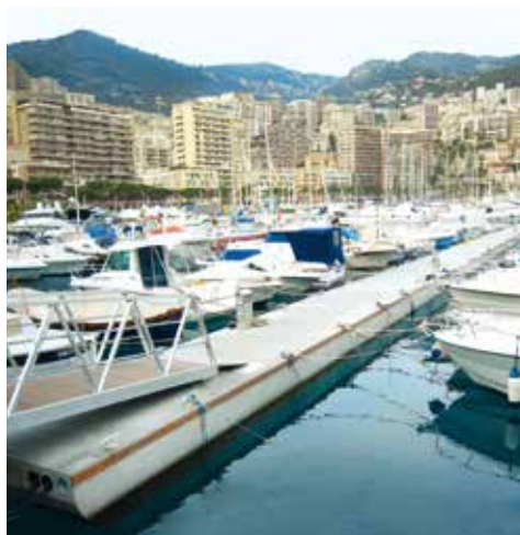
Pontile tipo CA/CLS con impianti nel calpestio
