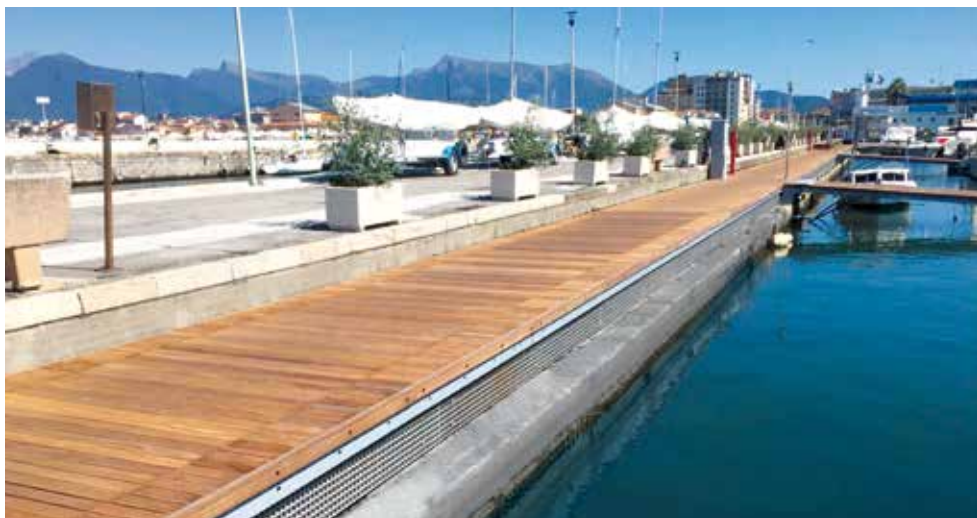
Ristrutturazione banchina fissa, Approdo La Madonnina, Viareggio
