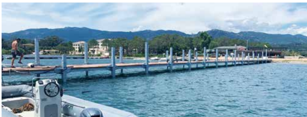
Pontile prefabbricato su pali rimovibile, Porto Vecchio Marine - Francia
