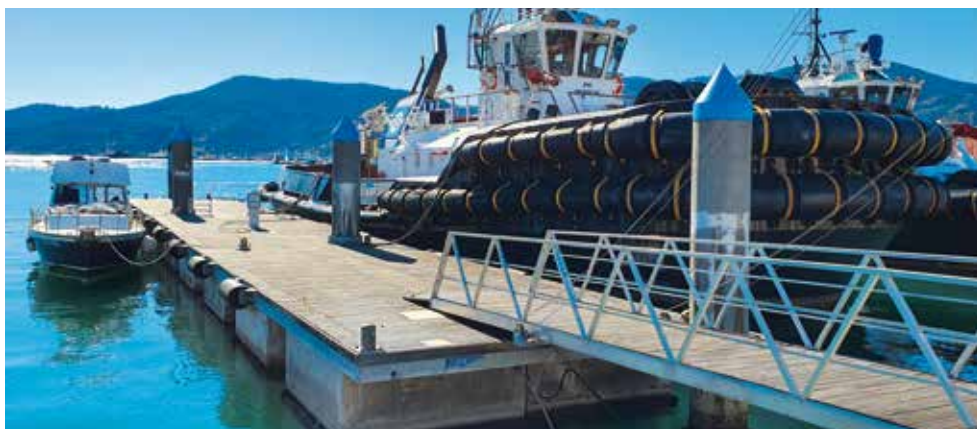
Moli per ormeggio rimorchiatori, Autorità del Sistema Portuale del Mar Ligure Orientale, La Spezia
