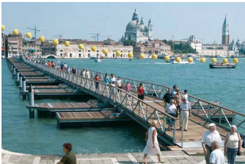
Ponte del Redentore, Canale della Giudecca - Venezia
