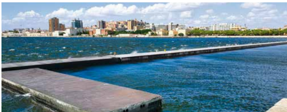
Frangionde F/CA 12x3m, Autorità del Sistema Portuale del Mare di Sardegna, Cagliari
