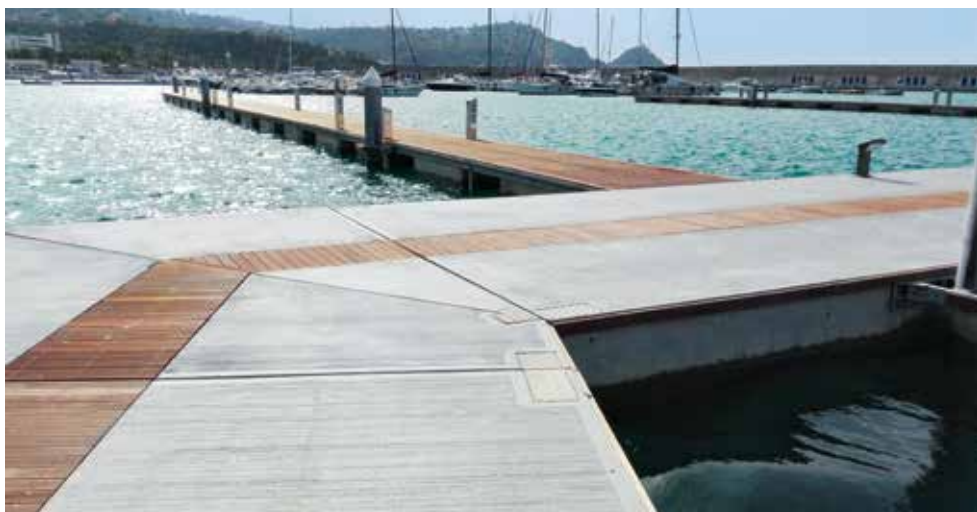
Molo galleggiante CA/CLS in elementi assemblati rigidamente, Capo d'Orlando - Messina
