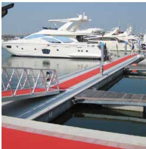
Pontile tipo CA/CLS con canalette laterali
