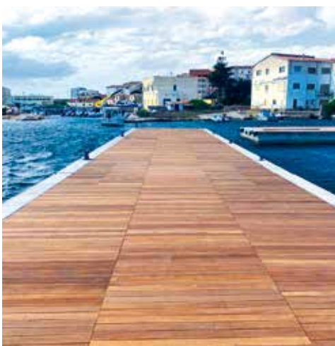
Pontile tipo CA/LE con finitura laterale in granito
