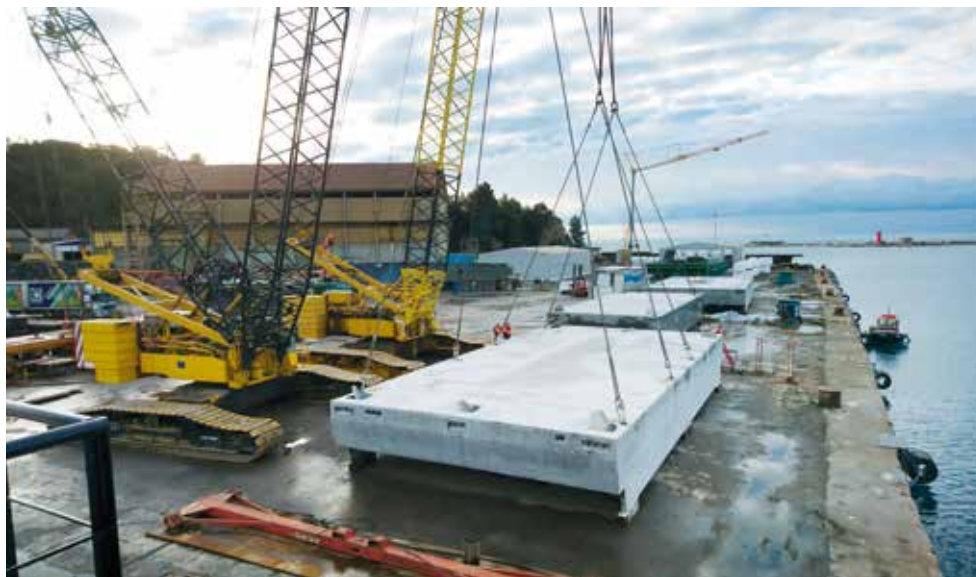
Cantiere produzione frangionde 20x8 m e 20x10m a La Spezia
